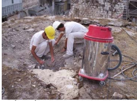
استخدام ماكنات الشفط في عملية تنظيف الأوساخ والأتربة المتساقطة حول الشقوق الظاهرة من السقف
