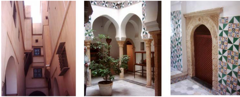
شكل رقم(8.2): لقطات في داخل قصر رؤساء البحر- الجزائر بعد انتهاء اعمال الترميم (الباحث)
