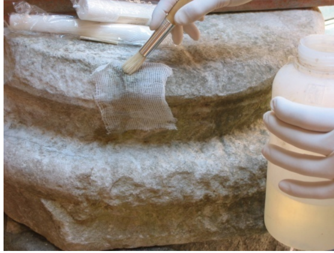
شكل رقم(2): تنظيف السطح من الفطريات المسببة للتآكل (Docci, 2005)
