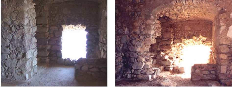
شكل رقم (6): إعادة بناء الأجزاء المتهدمة من أجل زيادة قوة الجدار و منعه من التدهور (Docci, 2005)
